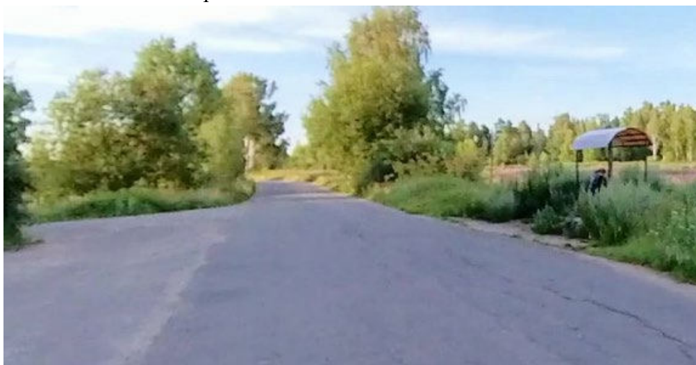
Рисунок 3.2.1. Пример остановочного пункта маршрутного транспорта на а/д «Озерки – Редкино» без необходимого оснащения
