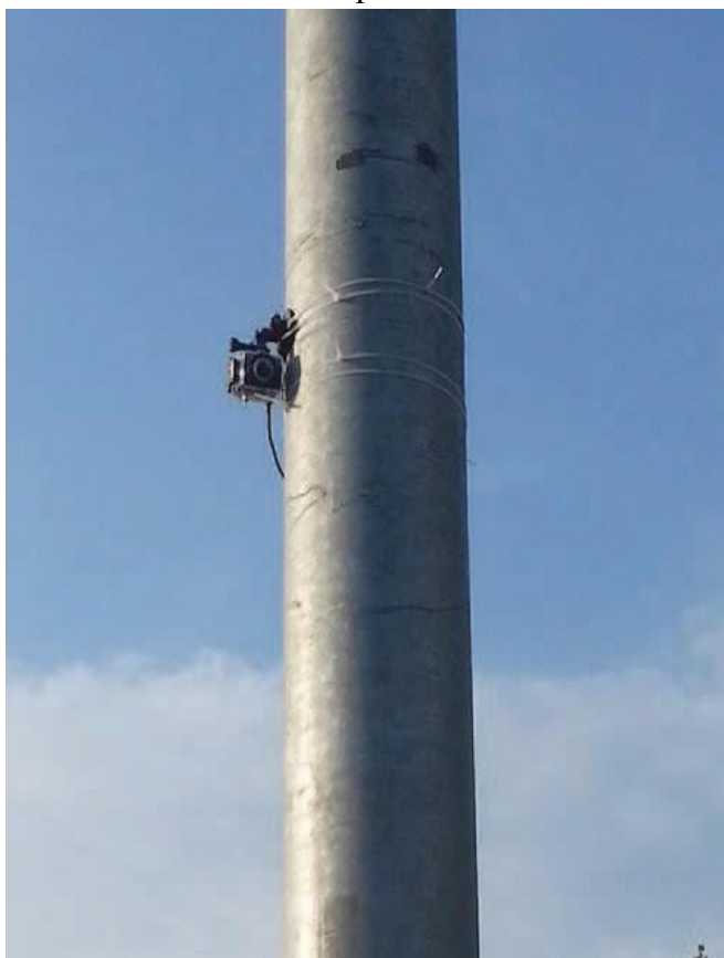
Рисунок 1.5.1.2. Монтаж видеокамеры на столб линии электроосвещения
